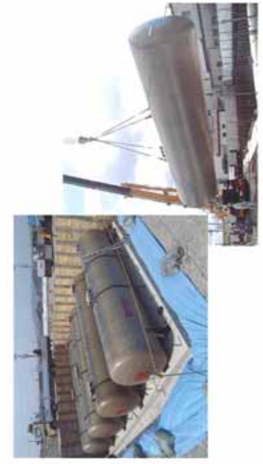
■設置例 タンクの大径化に伴い工場製作最大径の12000タンクを製作可能
