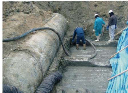
漏えいによる汚染土壌回収作業中
