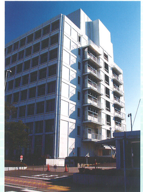
アイシン精機株式会社 事務本館 全館GHP化工事
