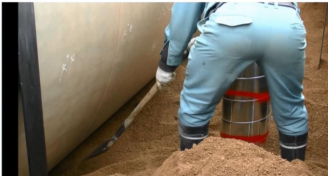
タンク下部への埋め戻し材充填作業
