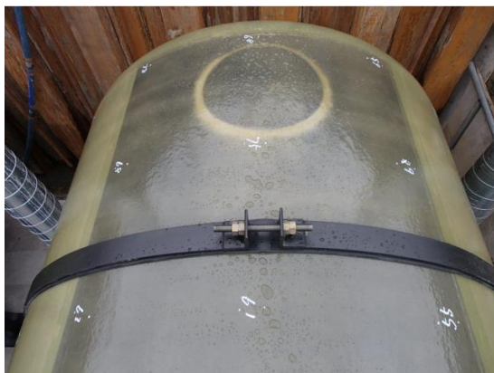
タンクバンドボルト防錆前
