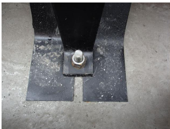
アンカーボルト防錆前
