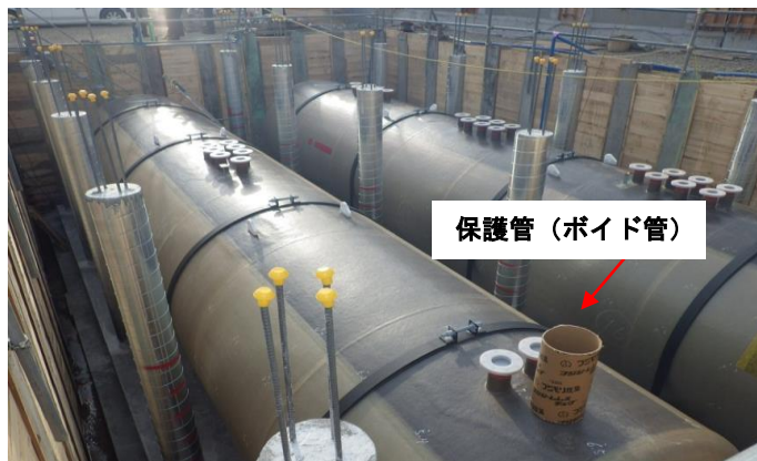
保護管設置状況
