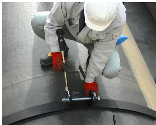
タンクバンド固定作業状況
