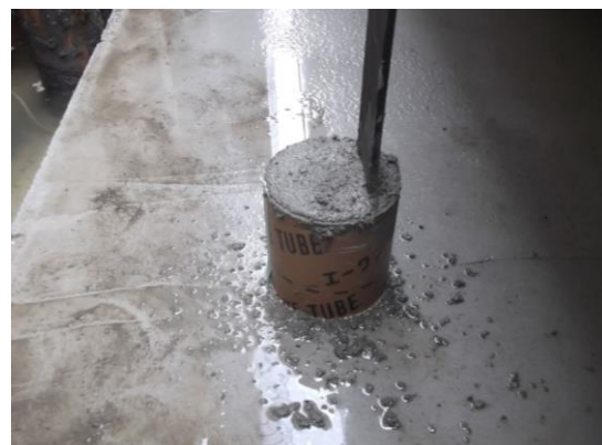
アンカーボルトモルタル保護（拡大図）
