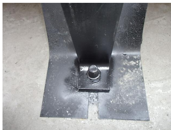
アンカーボルト防錆後
