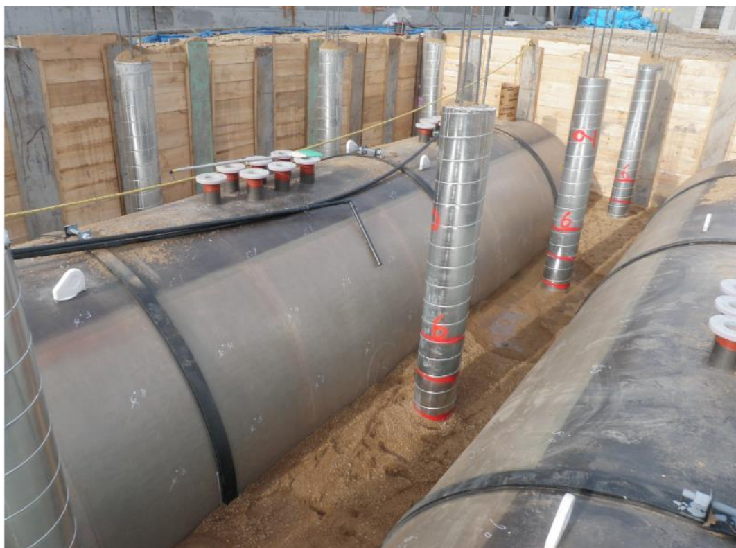
タンク中心まで埋め戻し水締め完了
