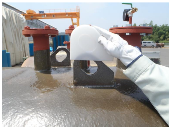
吊り金具へのカバー取付け
