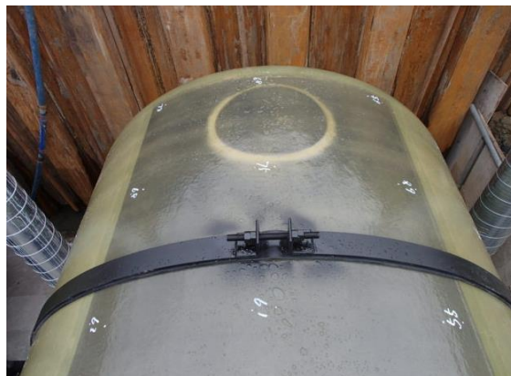
タンクバンドボルト防錆後
