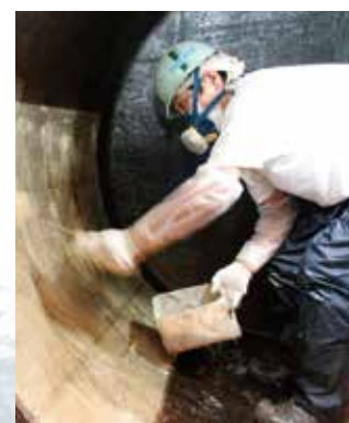
タンク内面FRP成形作業中
