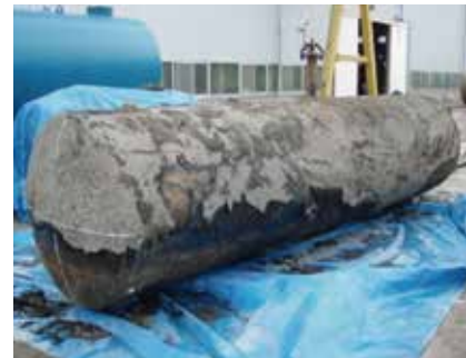
老朽化した地下タンク
