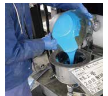
配管コーティング施工中
