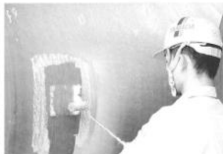
FRPの補修作業
