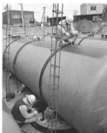
据え付け作業
