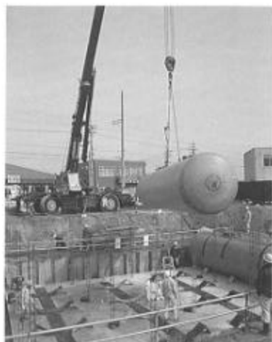
吊り込み作業
